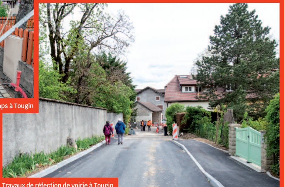
Travaux de réfection de voirie à Tougin
