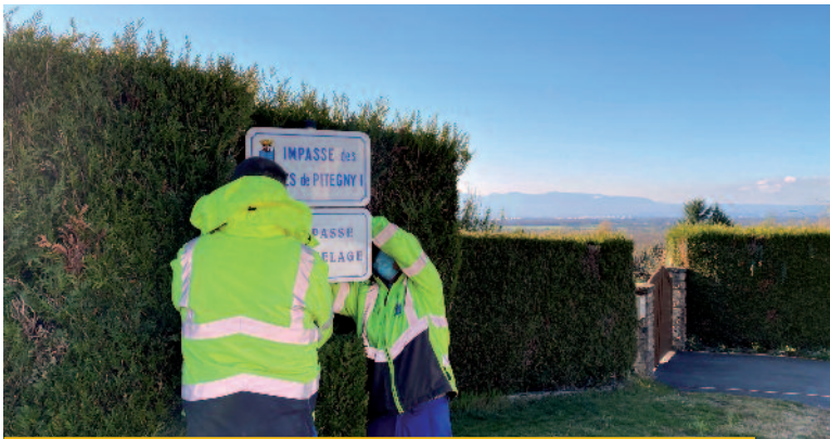
13 avril | Démarrage de la pose des plaques des nouvelles voiries - 820 foyers concernés par l'opération de changement de noms de rues.
