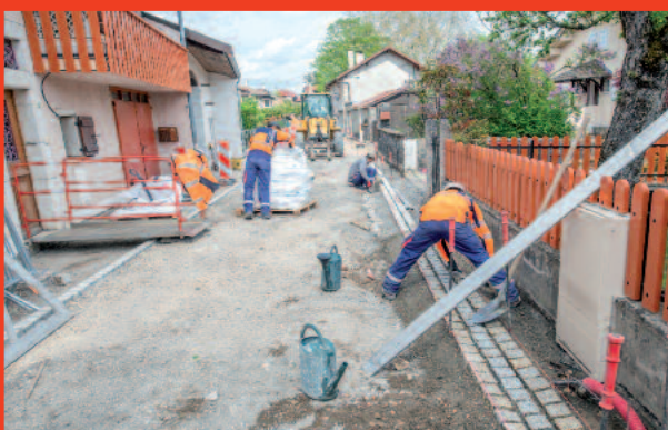
Réfection de voirie et trottoirs rue des Grands Champs à Tougin
