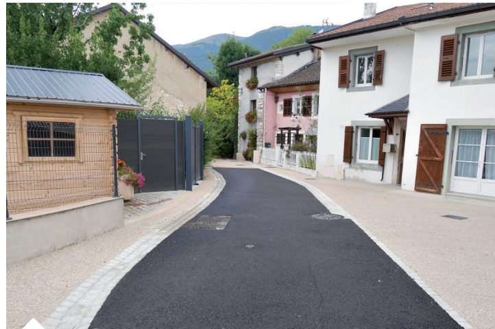
Travaux d'aménagement de la voirie à Tougny.
