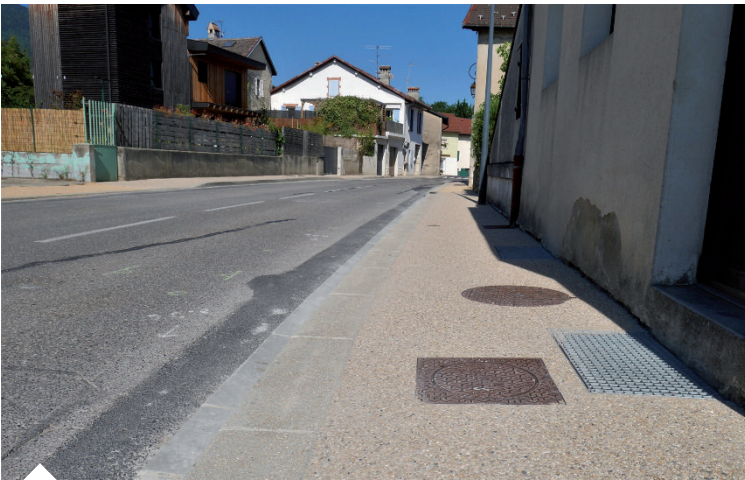
Travaux d'amélioration de la voirie rue de Gex-la-Ville.
