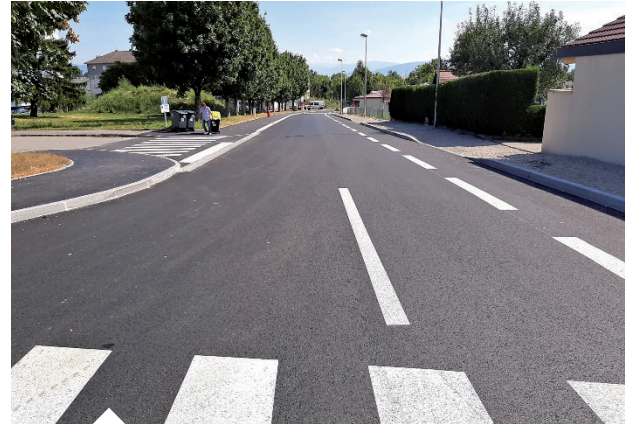
Réfection de la voirie rue Charpak.
