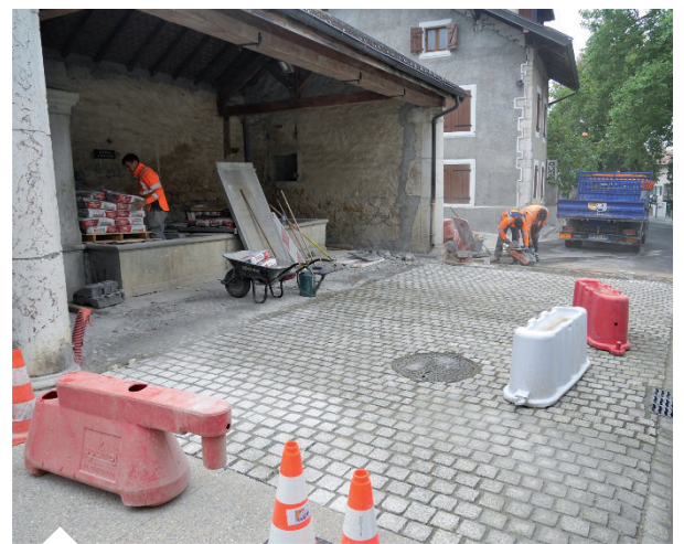
Travaux d'aménagement à Tougny.
