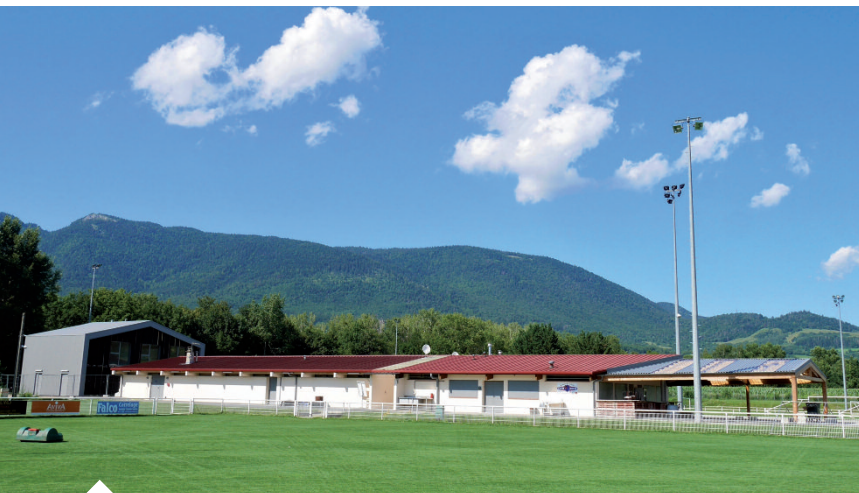
Travaux de rénovation et d'extension au centre sportif de Chauvilly.
