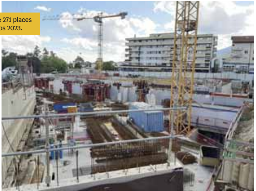
Le chantier du centre de tri de La Poste en zone de l'Aiglette.
